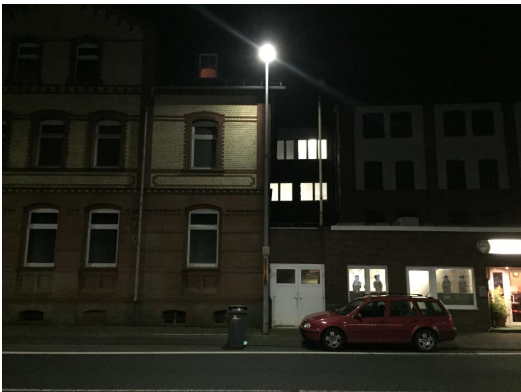
Sinn nach der Umrüstung 35/24 Watt
