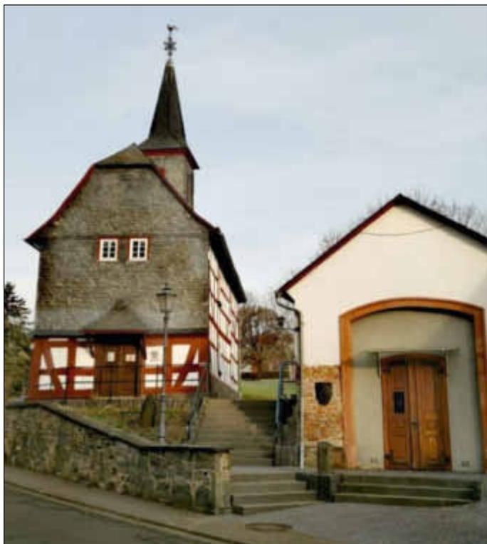
Die komplette Treppenanlage wurde abgetragen und neu aufgebaut, das Gelände durch ein ortsansässiges Unternehmen neu gefertigt und in seiner Höhe an aktuelle Anforderungen angepasst. Dabei wurde auch Altes erhalten. So hat man die geschwungenen Endungen des Handlaufs
